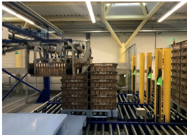
Рис. 2. Процесс транспортировки замороженной плазмы из хранилища на производство
